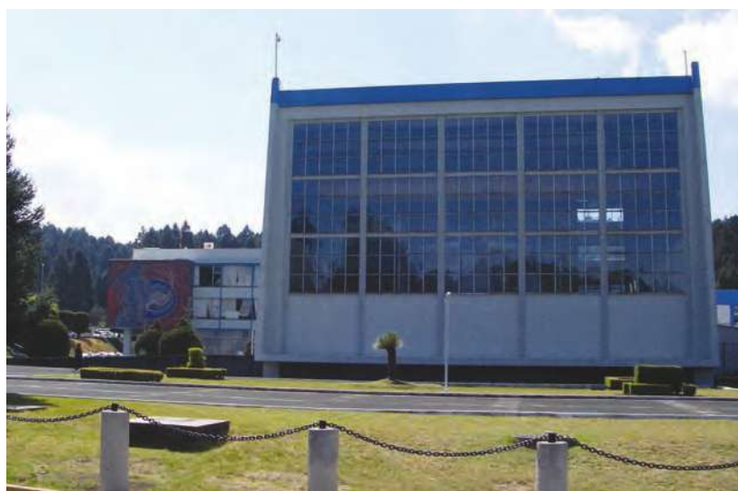
Foto 8. Edificio del reactor.
