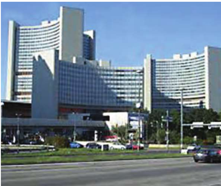
Foto 14. Sede del OIEA en Austria, Viena.
