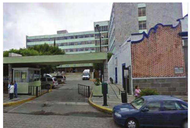
Foto 138. Hospital General del IMSS de Puebla.
